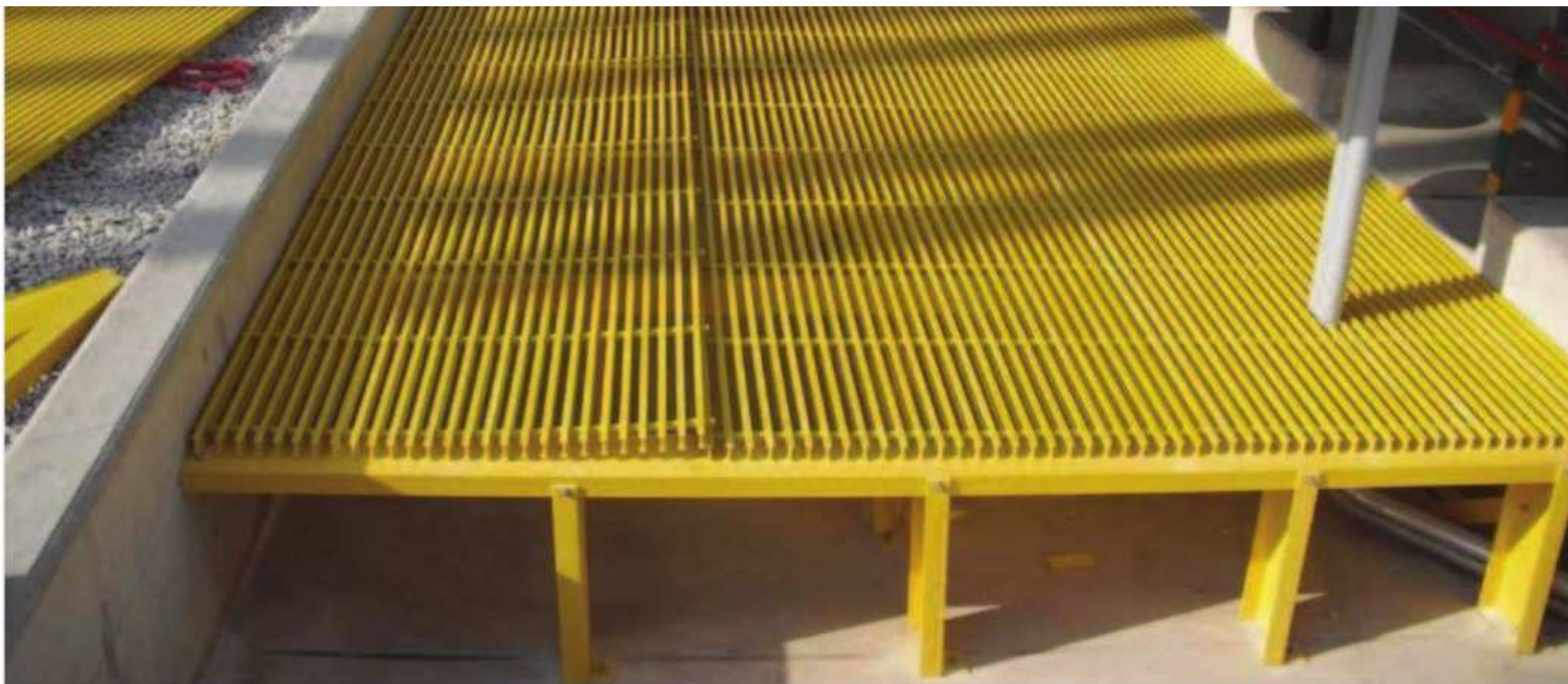
گريٲنگ FRP در سكوٲ تجهيزات صنعتي - كفپوش دسترسي سبك، ضد لغزش و عايق الكتريكي در مجاورت تجهيزات برقي.
